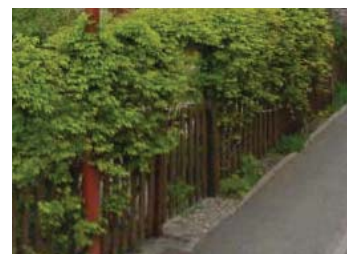
Clôture à claire-voie en bois.
