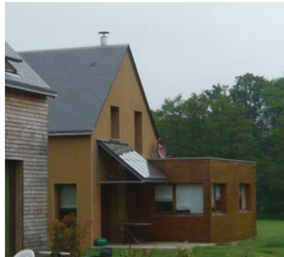
Panneau solaire utilisé comme auvent
