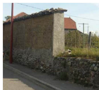
Mur en pisé, soubassement en galets
