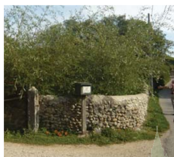
Mur en galets
